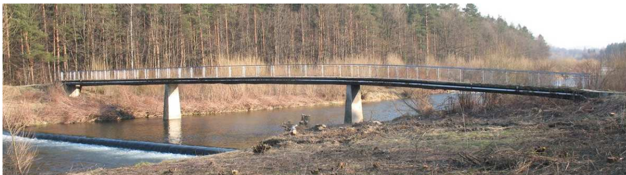
Fot.1 Widok kładki od strony dolnej wody
